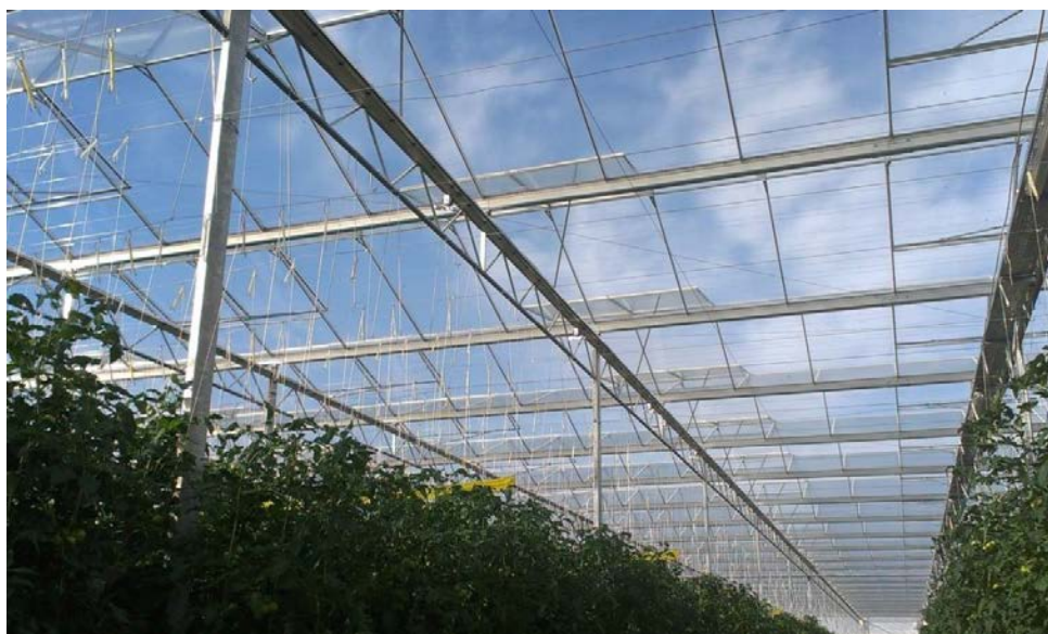
Obrázok 11 Strešná ventilácia skleníka (foto: Šlosár, 2013)
