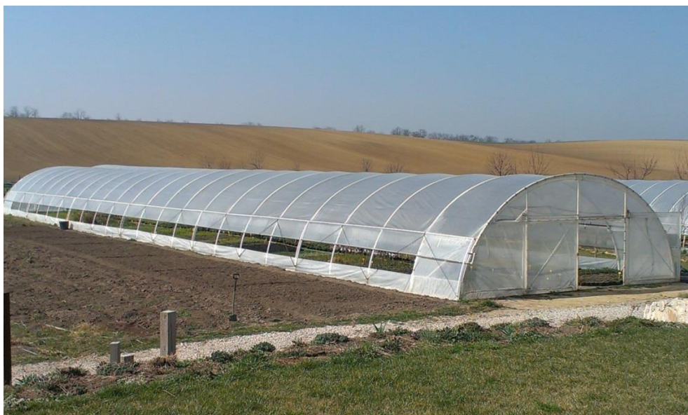
Obrázok 12 Rolovateľná bočná stena a čelná ventilácia jednolod'ového fóliovníka (foto: Šlosár, 2014)
