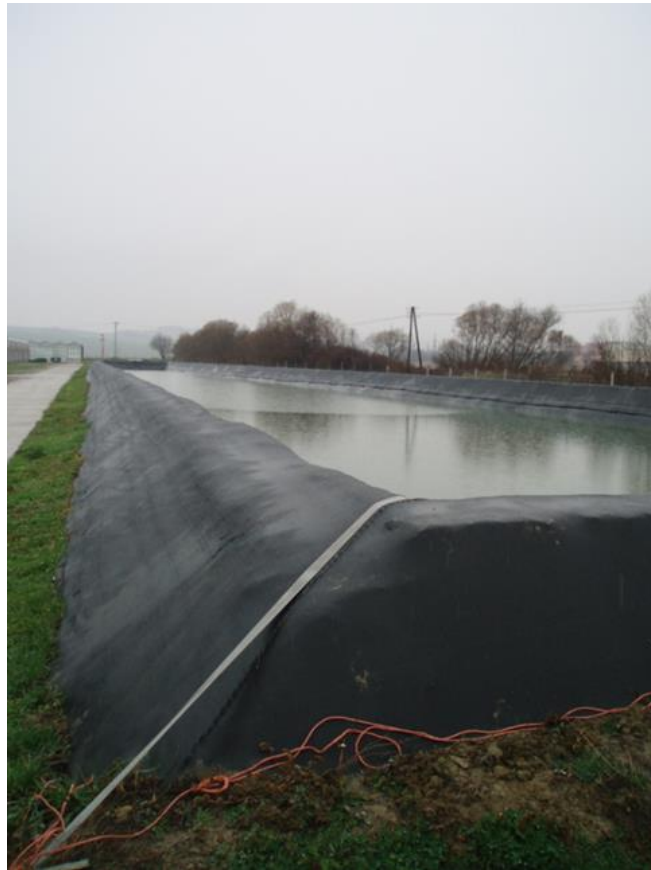
Obrázok 15 Retenčné nádrže na zachytávanie zrážkovej vody (foto: Šlosár, 2009)
