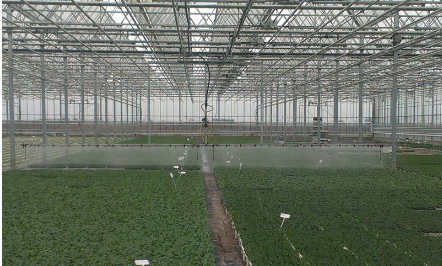
Obrázok 17 Závlahový most v skleníku (foto: Šlosár, 2015)
