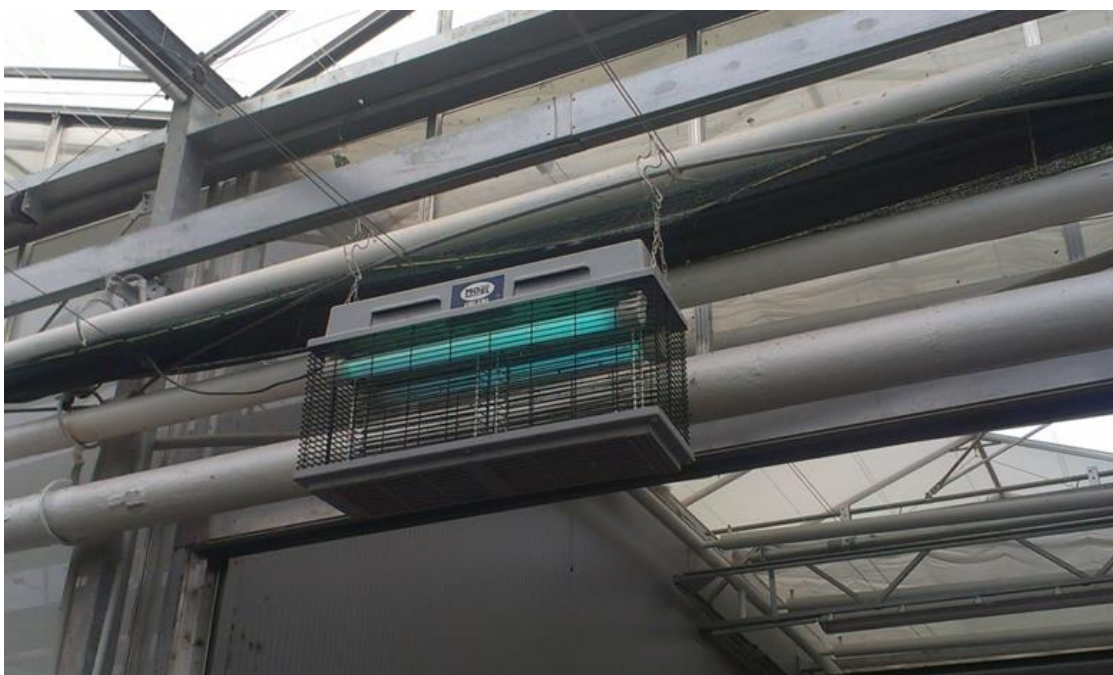
Obrázok 24 UV lampa proti lietajúcemu hmyzu umiestnená nad vstupom do pestovateľského priestoru skleníka (foto: Šlosár, 2015)
