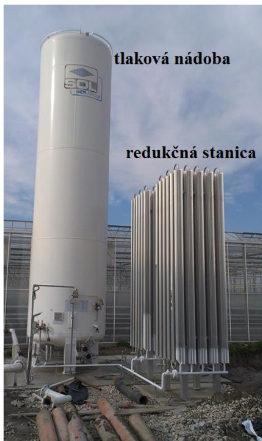
Obrázok 20 Tlaková nádoba a redukčná stanica CO 2 (foto: Šlosár, 2013)
