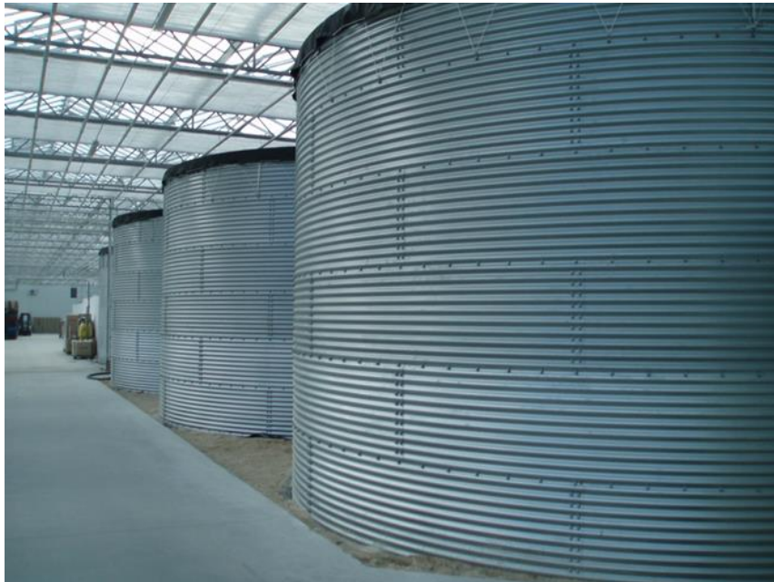
Obrázok 16 Nádrže na miešanie podzemnej a zrážkovej vody (foto: Šlosár, 2015)
