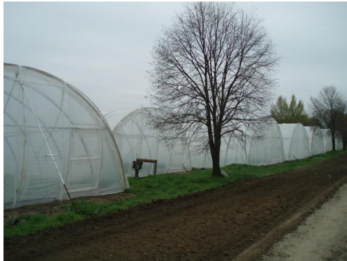
Obrázok 7 Jednolod'ový fóliovník (foto: Šlosár, 2011)
