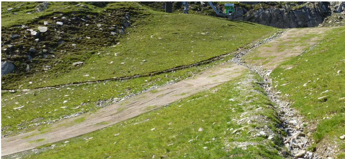
Obr. 5.5 Zatrávňovanie svahu pod sieť
