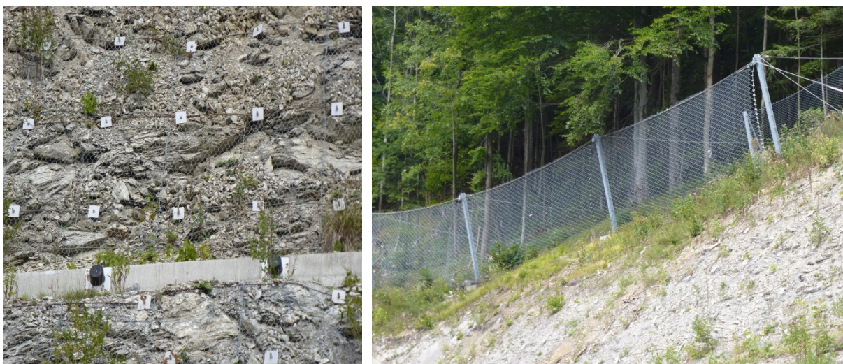
Obr. 8.10 Opláštenie svahu (vľavo) a dynamická bariéra proti padaniu skál (vpravo)
