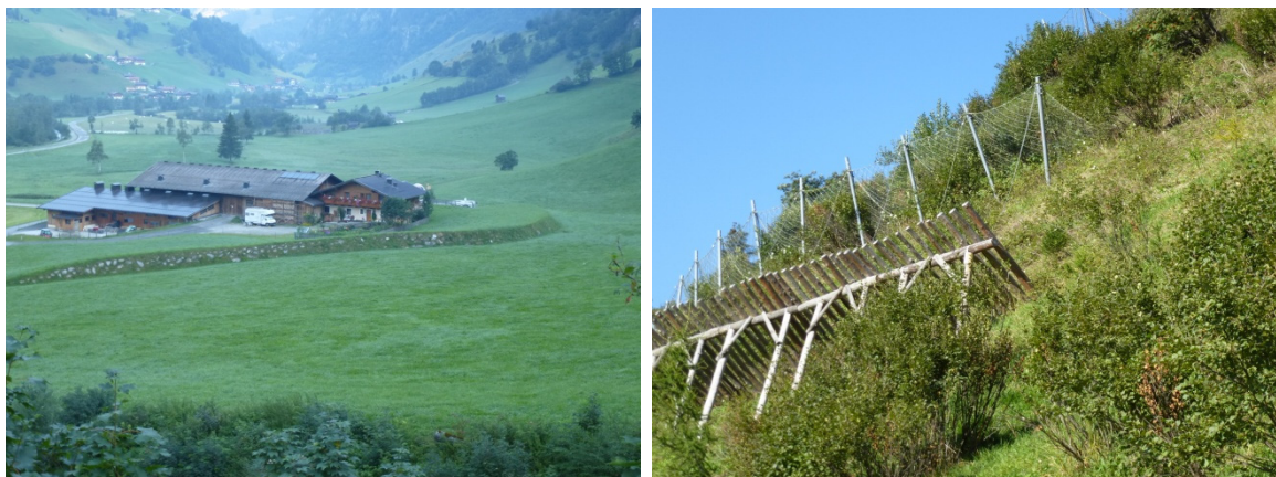
Obr. 10.11 Protilavínové opatrenia - ochranná hrádza (vľavo), kombinácia siete a drevených snehových hradlí (vpravo)
