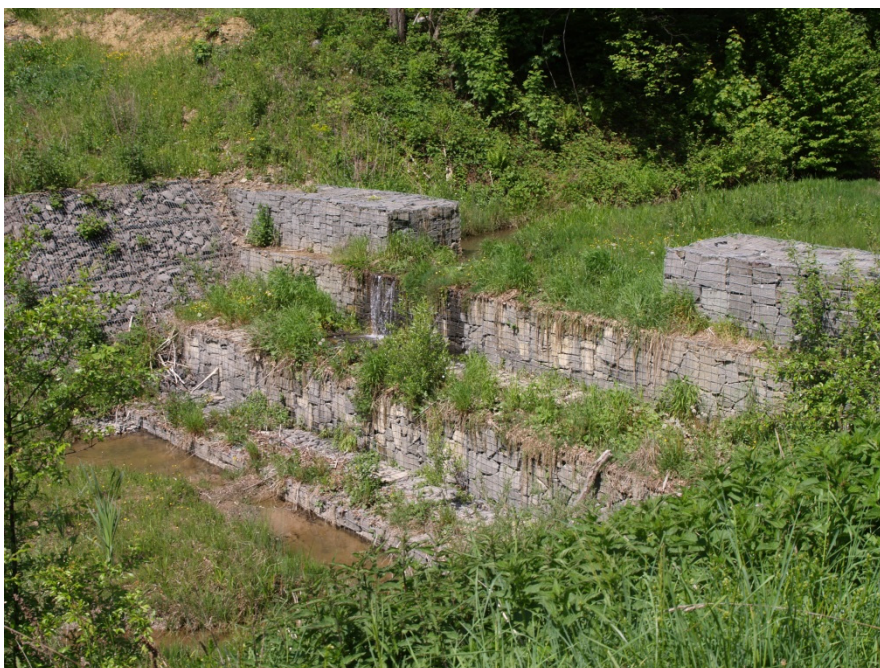
Obr. 11.4 Stupňovitá drôtokamenná prehrádzka (Foto: Jurik)
