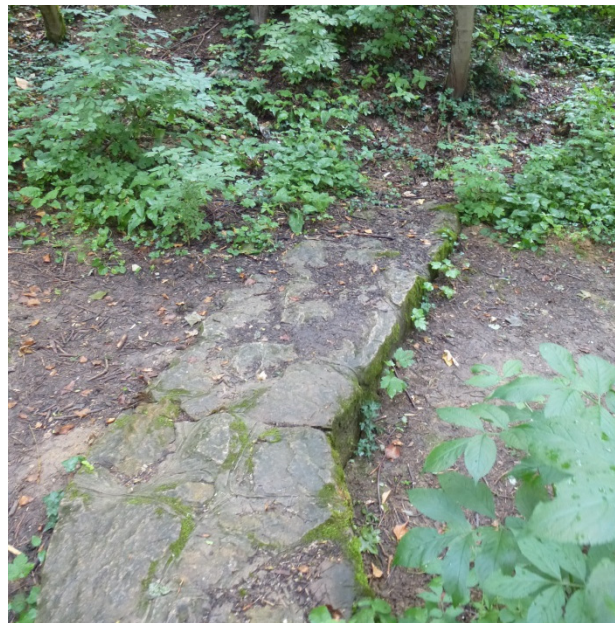
Obr. 11.7 Zapustenie krídla prehrádzky do svahu
