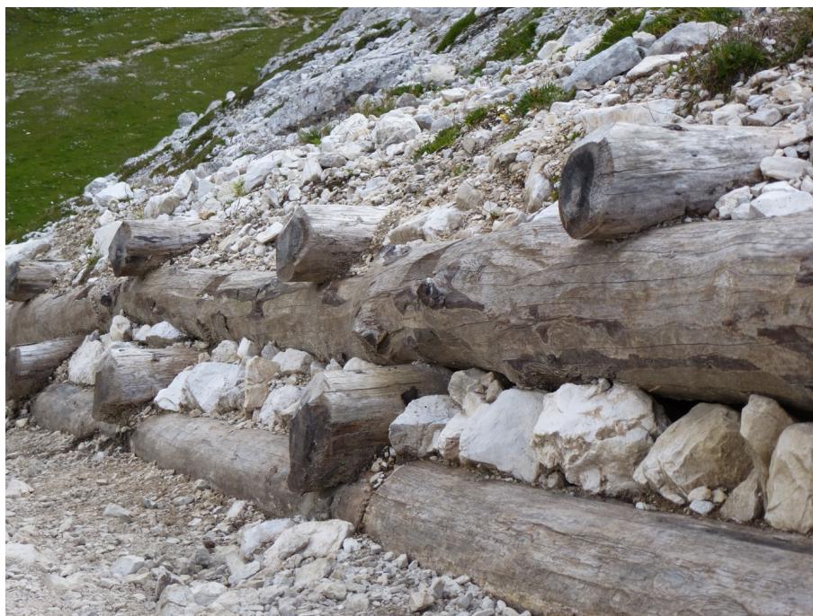
Obr. 8.7 Zrubový múr stabilizujúci svah
