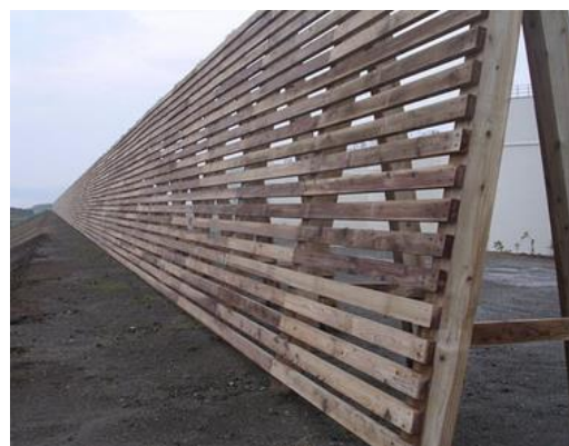
Obr. 2 Aerodynamická bariéra vyhotovená pomocou drevených perforovaných stien
